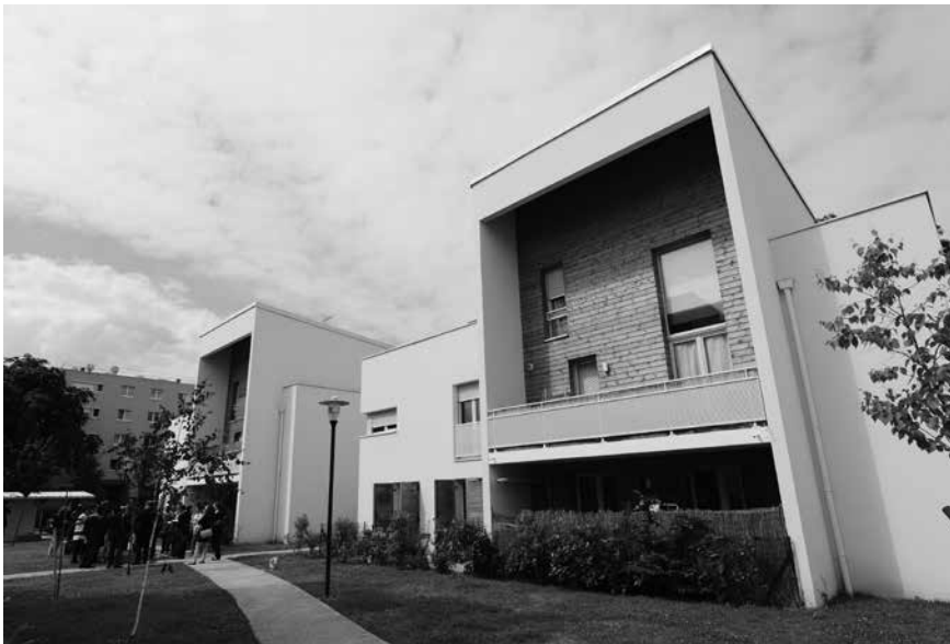
Prototipos de nuevas viviendas sociales del barrio de renovación urbana de Le Noyer Renard en Athis-Mons.
